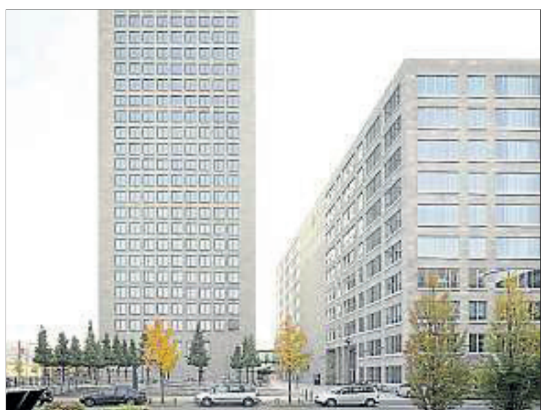
Der IBC-Gebäudekomplex gegenüber der Frankfurter Messe. Foto: GEG
