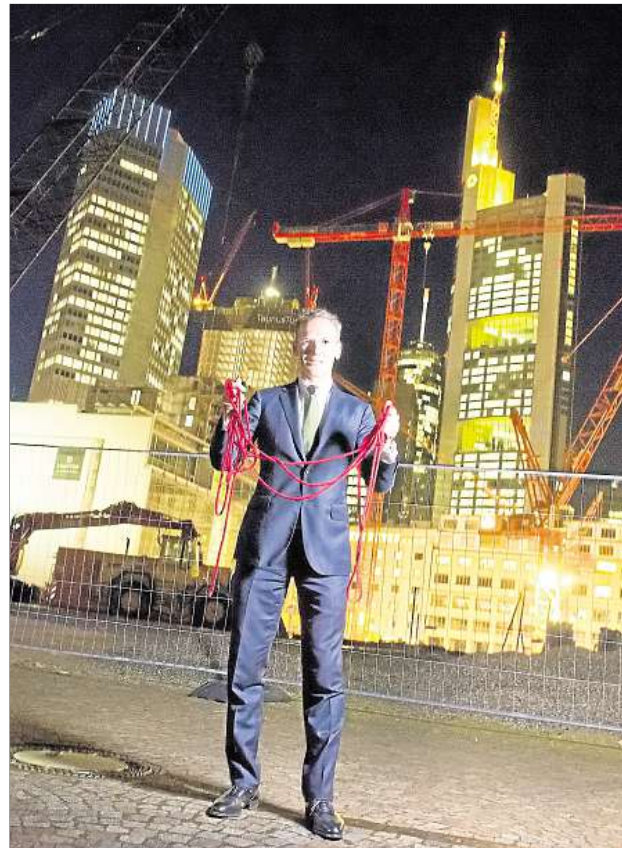
Ulrich Höller vor der Baustelle, auf der das „Main-Tor“-Viertel entsteht.
