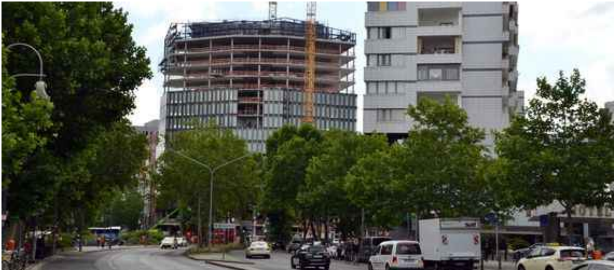
Das im Bau befindliche Bürotürmchen The Westlight in der City West ging für 200 Mio. Euro von Barings an ein Konsortium aus Generali Real Estate und Poste Vita. Quelle: Immobilien Zeitung, Urheberin: Lea Gericke
